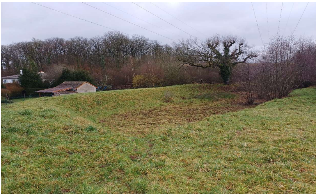
Bassin communal de stockage-régulation
